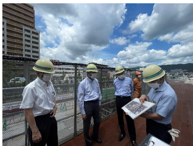
現場巡視(延伸工事)
