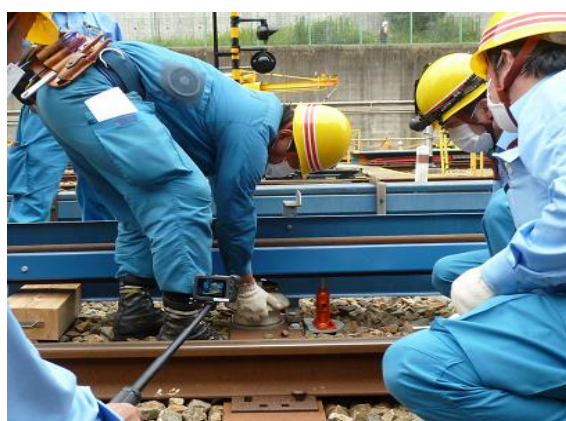
サードレール復旧訓練
