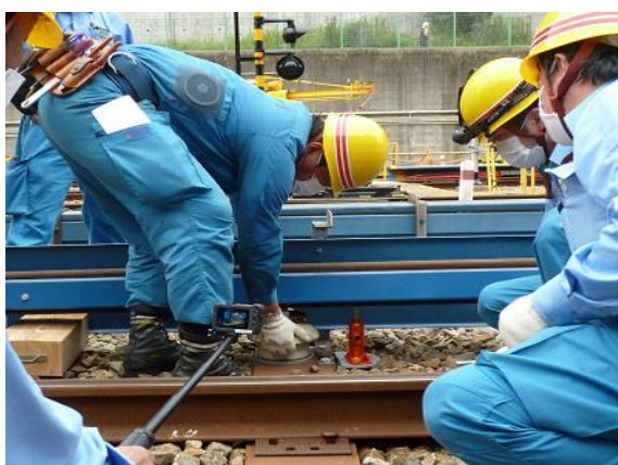
サードレール復旧訓練
