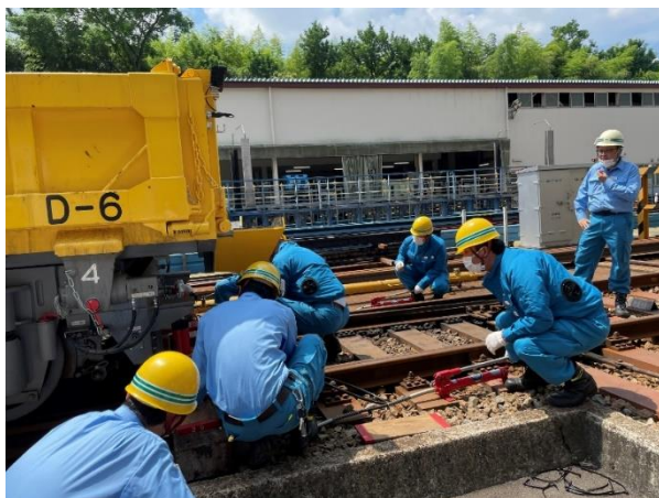
現場巡視（施設課）
