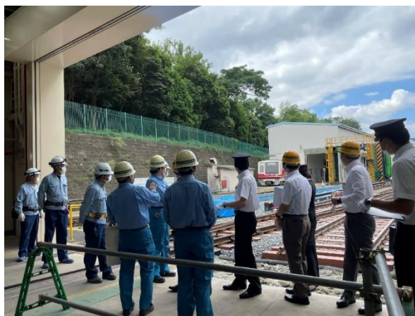
現場巡視（延伸工事）
