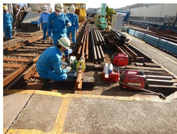
レール折損応急復旧訓
