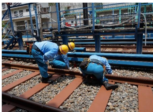
軌道復旧訓練
