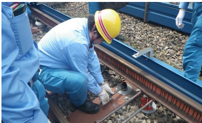
サードレール復旧訓練
