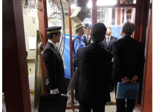
駅リニューアル工事視察（施設課）
