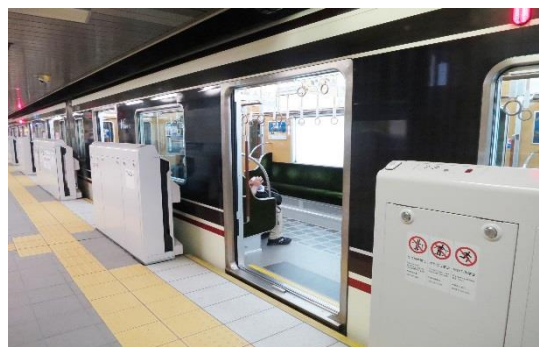
可動式ホーム柵が開いている状態
