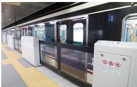
可動式ホーム柵が閉まっている状態
